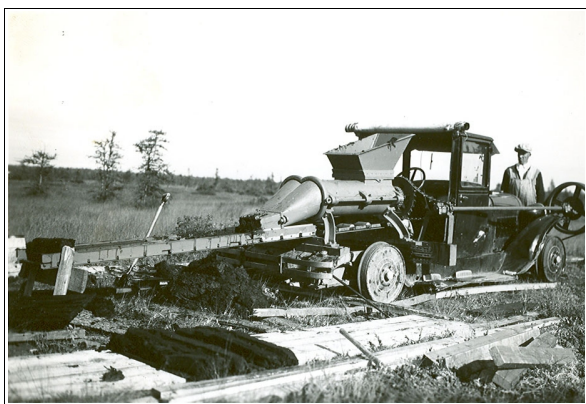
Figure 2.5. La machine à façonner la tourbe de type « Québec ». Elle est inventée en 1942 pour la fabrication des briques de tourbe combustible devant la crainte d'une pénurie de bois de chauffage... (Mercier, 1942).
