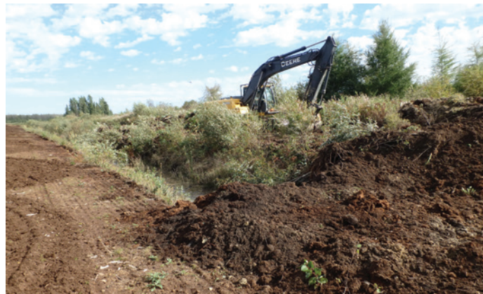
Figure 6. Retrait du talus et comblement du fossé au site d'Elma au Manitoba.
