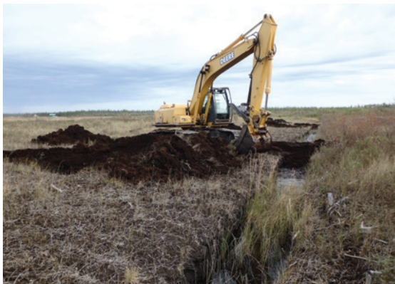
Figure 8. Blocage d'un fossé de drainage secondaire avec de la tourbe à la tourbière de South Julius au Manitoba.
