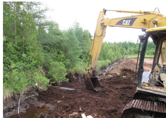
Figure 9. Blocage d'un fossé de drainage périphérique utilisant une palissade de bois couverte de géotextile en amont et de la tourbe à la tourbière de Bic-Saint-Fabien au Québec.
