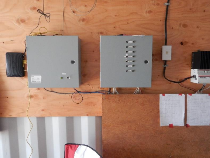
Figure 35 Installation du système énergétique à l'intérieur du conteneur. de gauche vers la droite, modem internet, panneau système central, panneau contrôle de la puissance et contrôleur de charge.
