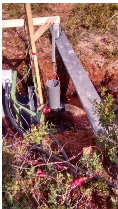
Figure 31 Installation d'un barrage à hauteur variable.
