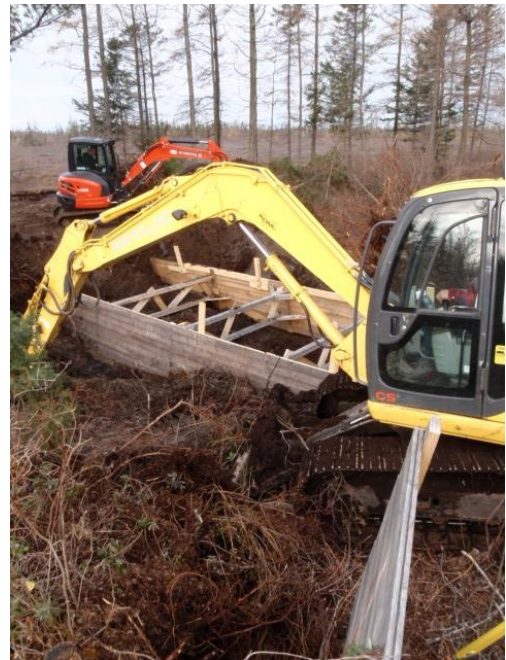
Installation d'un barrage dans le canal de drainage (photo : O. Marcoux)
