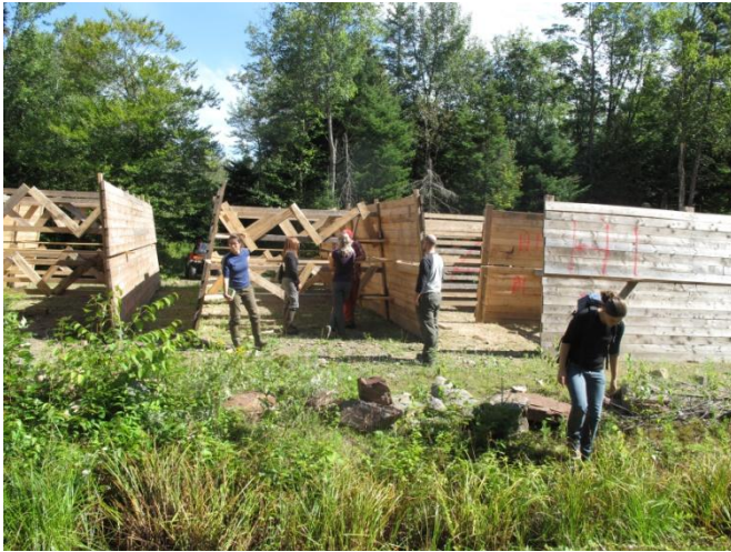
Barrages construits (photo : G. Ayotte)
