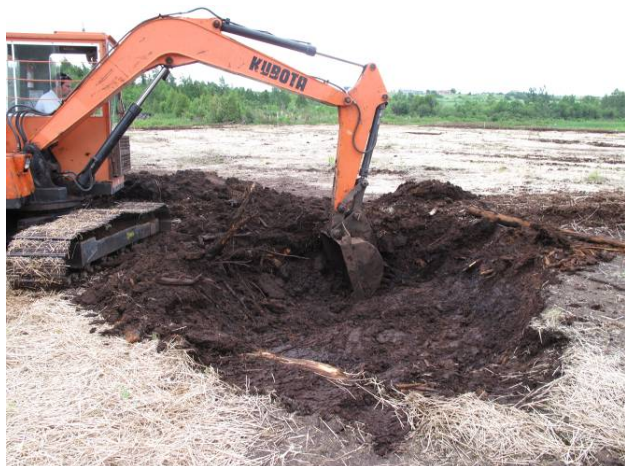
Création d'une mare profonde à l'aide de la pelle mécanique.
