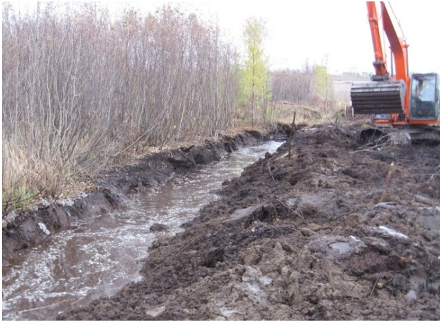
Nettoyage du canal de drainage pour la sortie d'eau et création d'une digue. Photo : Vicky Bérubé.
