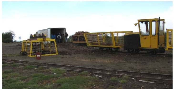
Type de chariot pour transporter la tourbe sur rail et zone de chargement de tourbe dans un camion-remorque.
